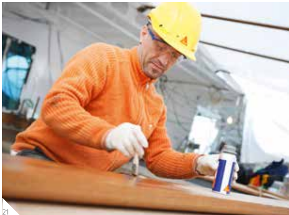
Abb. 21: Primer-Auftrag mit einem Pinsel
