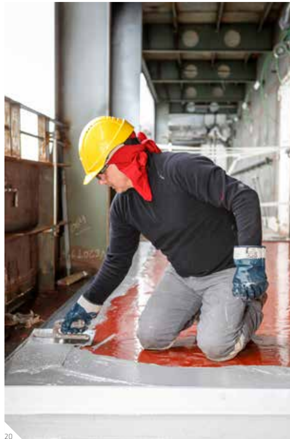
Abb. 20: Verteilen von SikaTransfloor®-352 SL mit einer Kelle
