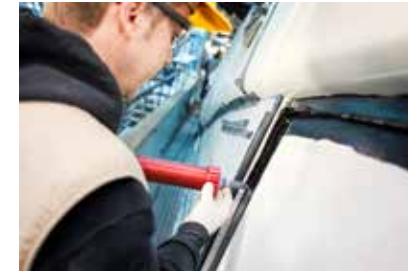
Abb. 82: Klebstoffapplikation auf die Einfassung
