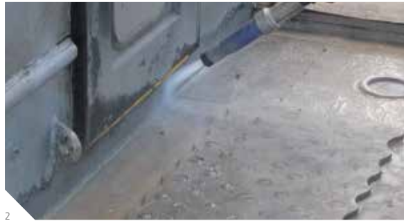
Abb. 2: Sandstrahlen
