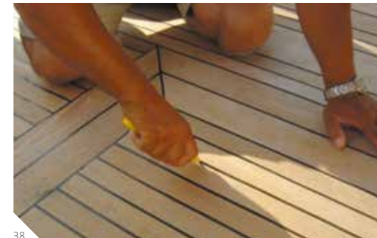
38 Abb. 38: Mit einem Cuttermesser wird in die zu entfernende Fuge eingeschnitten
