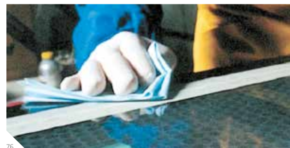
Abb. 76: Auftrag von Sika® Aktivator
