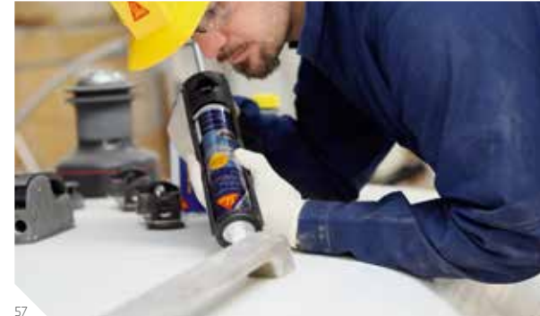
Abb. 57: Abdichten der Flanken einer Scheuerleiste aus Chrom
