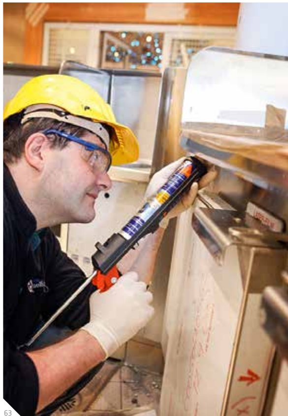
Abb. 61: Flächige Verklebung von Dekorplatten
