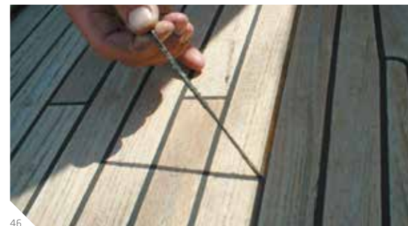
Abb. 46: Ausgeschnittene dreieckige Raupe des alten Fugenmaterials wird von Hand aus der Fuge gezogen
