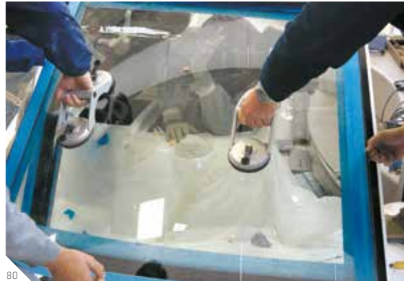
Abb. 80: Fenster einsetzen
