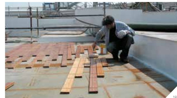
Abb. 17: Auftrag von SikaCor® ZP Primer mit einer Walze auf ein Stahldeck
