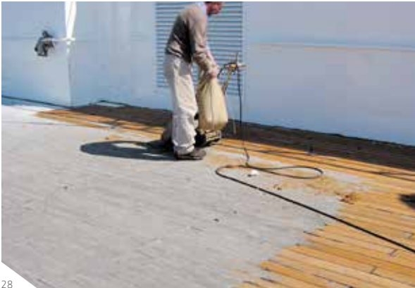
Abb. 28: Deck mit einer Industriebandschleifmaschine abschleifen
