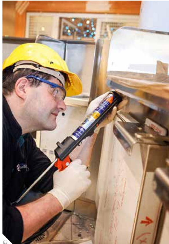
Abb. 61: Flächige Verklebung von Dekorplatten
