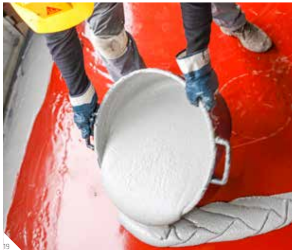
Abb. 19: Ausgießen des fertig angerührten SikaTransfloor®-352 SL auf das Deck
