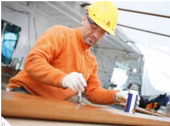
Abb. 21: Primer-Auftrag mit einem Pinsel
