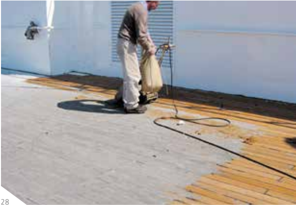
Abb. 28: Deck mit einer Industriebandschleifmaschine abschleifen
