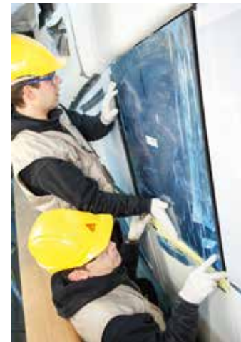
Abb. 83: Die Scheibe kann direkt nach dem Fügen noch ausgerichtet werden
