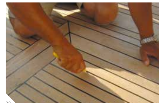
38 Mit einem Cuttermesser wird in die zu entfernende Fuge eingeschnitten
