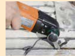
Abb. 40: Entfernen der Dichtfugen
