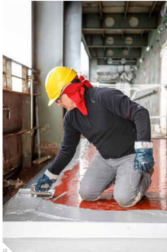
Abb. 20: Verteilen von SikaTransfloor®-352 SL mit einer Kelle
