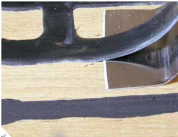
Abb. 47: Trennen der Leisten mit einer Vibrationssäge
