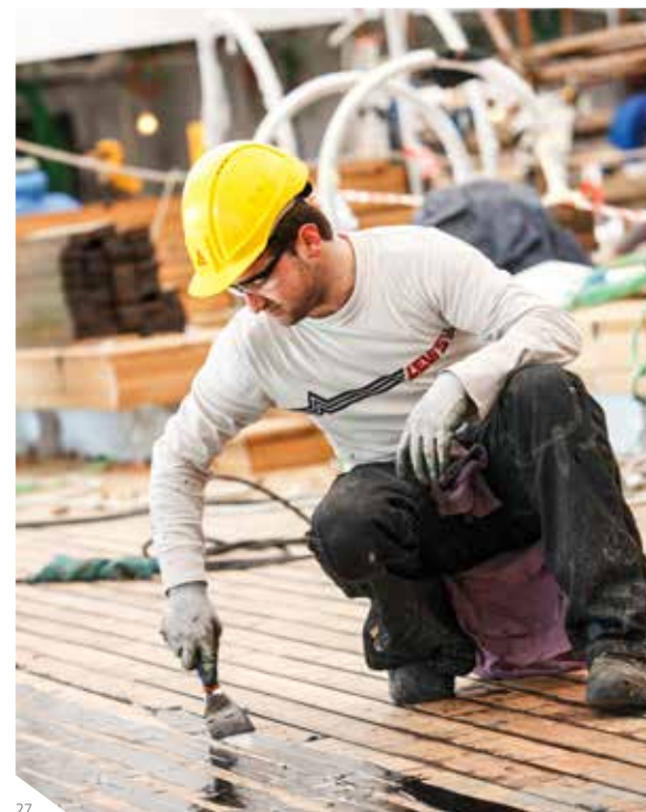
Abb. 27: Sikaflex®-290 DC PRO mit einem Spachtel abziehen und einpressen
