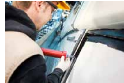
Abb. 82: Klebstoffapplikation auf die Einfassung
