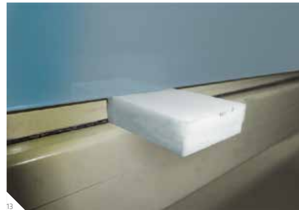
Abb. 13: Abstandsklotz im praktischen Einsatz
