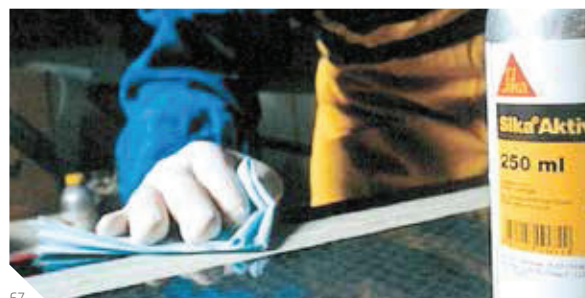
Abb. 67: Auftrag von Sika® Aktivator
