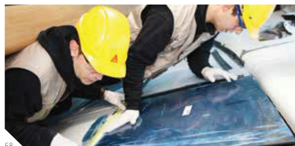
Abb. 68: Auftrag von Sikaflex®-296
