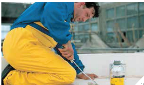
Abb. 13: Auftrag von SikaCor® ZP Primer mit einer Walze auf ein Stahldeck
