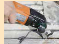
Fig. 3 Entfernen der Dichtfugen
