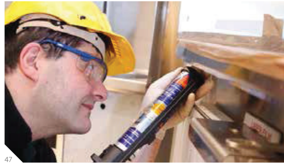
47 Abb. 47: Auftrag von Sikaflex®-292i
