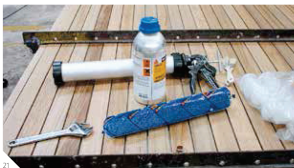
Abb. 21: Stabdeck zur Aushärtung eingespannt
