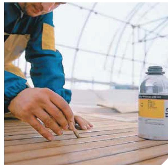
Abb. 17: Sorgfältiges Aufbringen von Sika® Primer-290 DC
